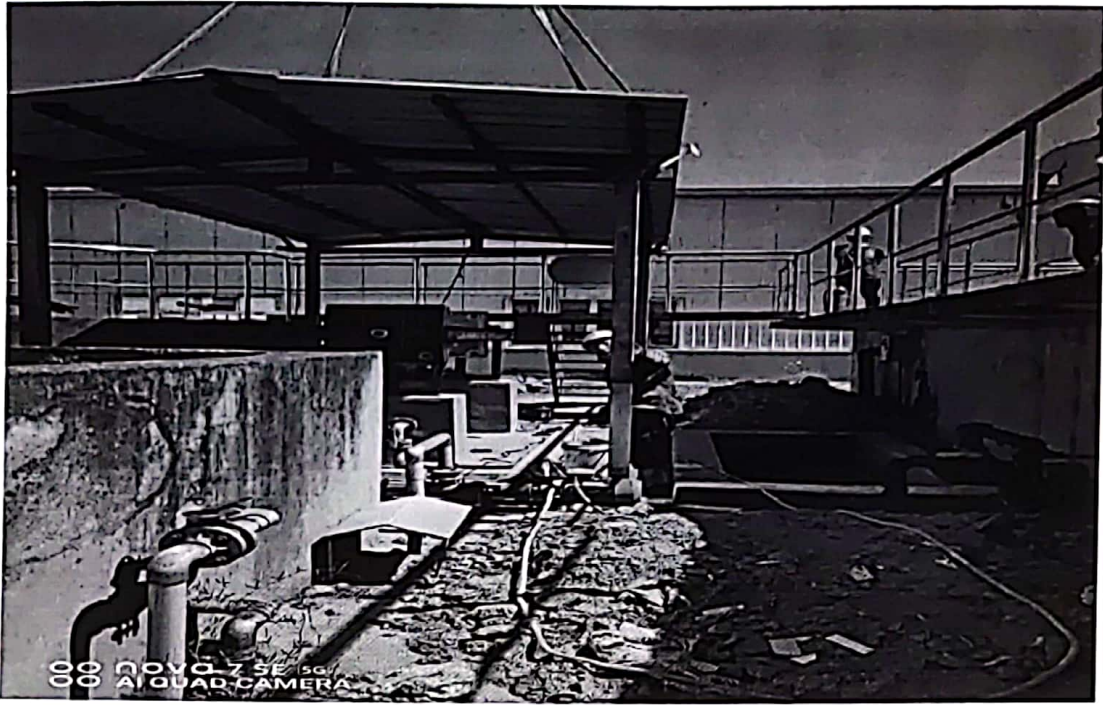
整改后抬高压滤机，增加压滤机滤液暂存池
