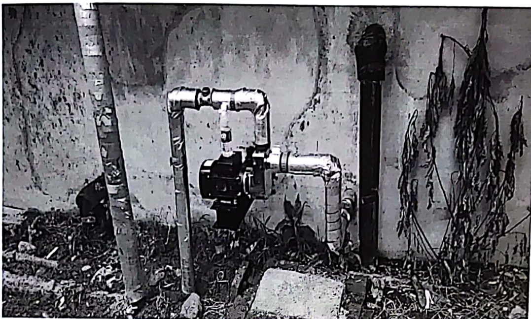
整改后增加污泥回流提升泵
